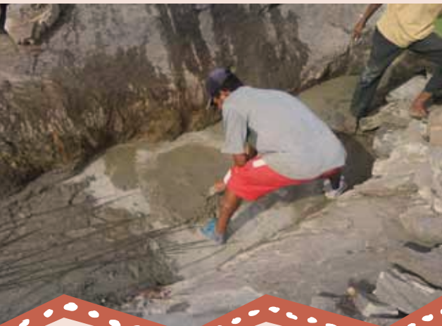
Foto 2 – Pedreiro rebocando fundo da cisterna com ferro e cimento
