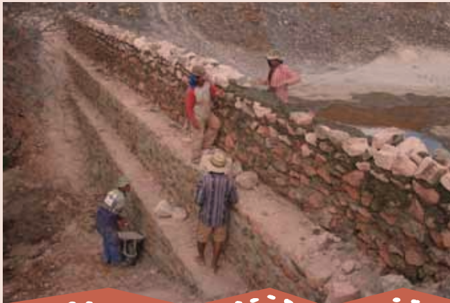
Fotos 3 – Construção da parede do tanque de pedra
